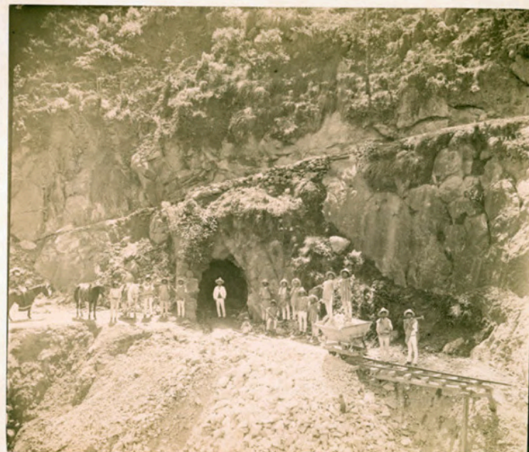
TÚNEL NEPTON del Mineral del Chico al de Pachuca. Ingeniero y operarios. Su longitud será de 12 kilómetros, con rumbo de S. 26° 45' E. sección 2" 50 x 2" 50, pendiente de 0" 50.0/0 y 2,014" 00 de altitud.
